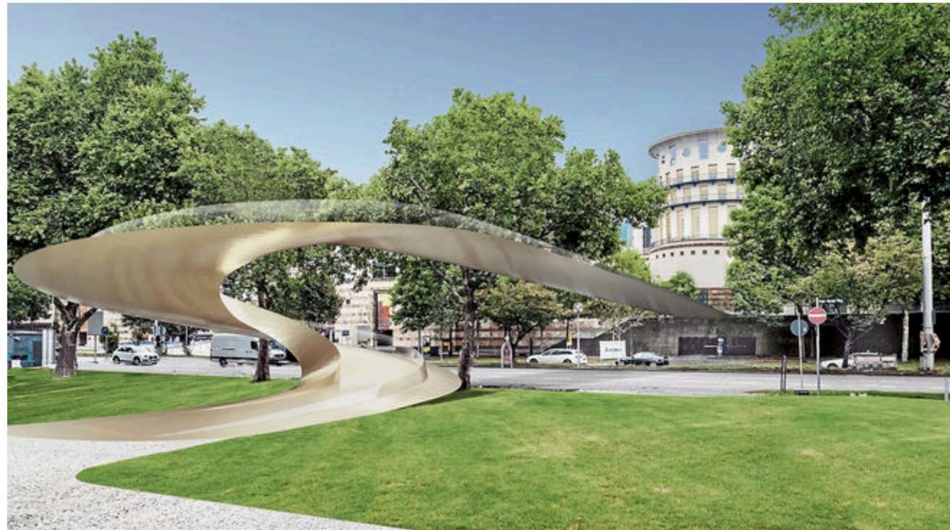
Eine filigrane Konstruktion, die ganz ohne Stützen auskommt: Wie ein „Goldenes Band“ könnte sich der von Werner Sobek entworfene Steg über die B 14 ziehen. Visualisierung: Werner Sobek, Stuttgart
