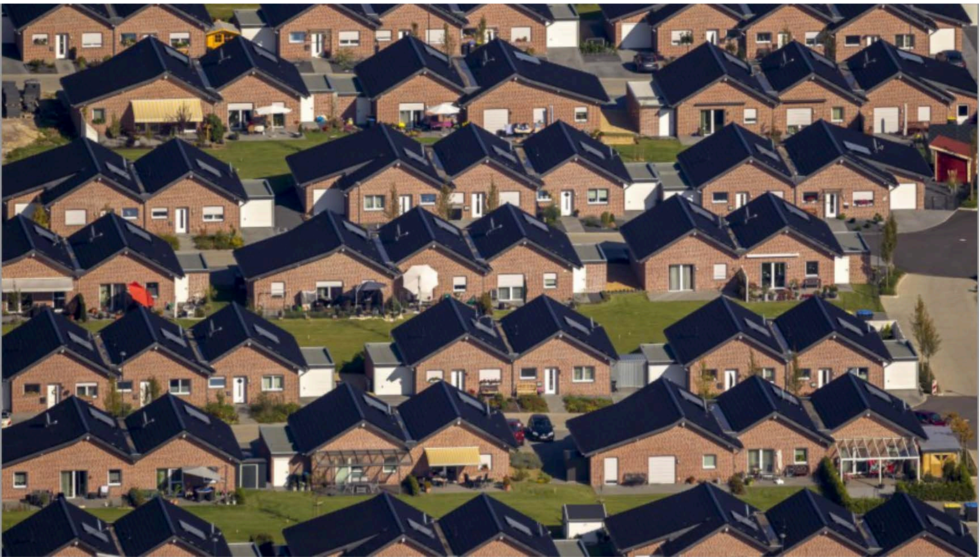
Zubetoniert: Neubausiedlung in Baesweiler.
